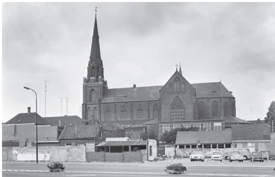
Kort na de aanleg van de Traverse stond de Lambertuskerk er ineens wat verloren bij.
